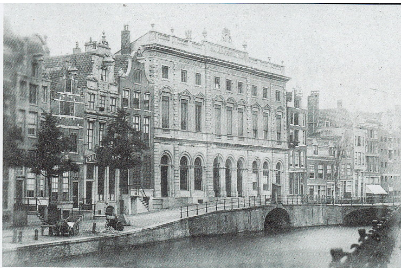
Afb. 16. Het Koninklijk Postkantoor Amsterdam van 1854 tot 1897, gevestigd op de Nieuwezijds Voorburgwal 192, circa 1895
